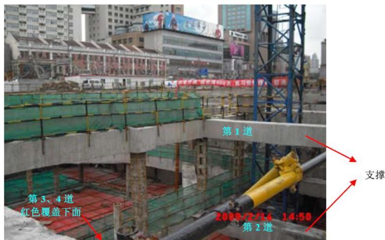
图 2 基坑支撑（加上红色覆盖下面的第 3、4 道支撑，共 4 道）
